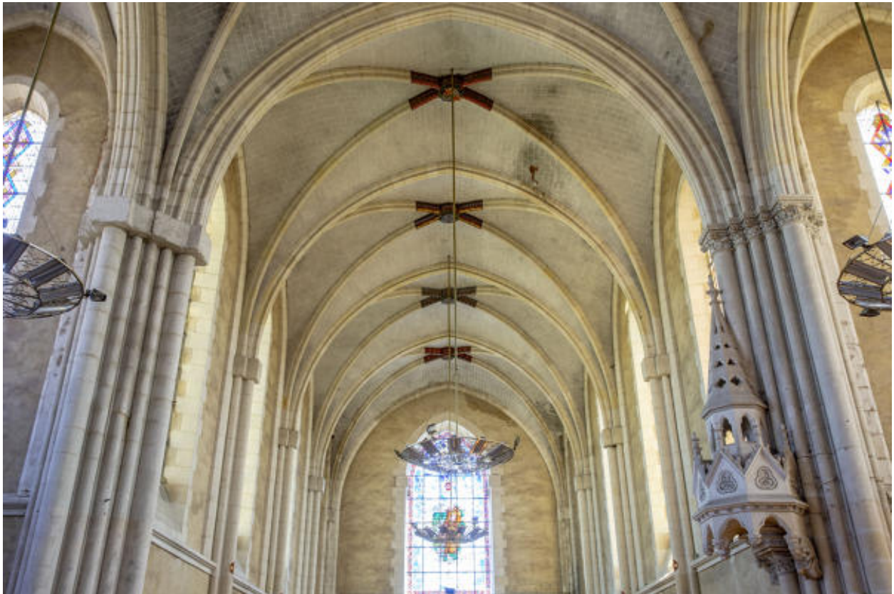
Un détail des voûtes.
