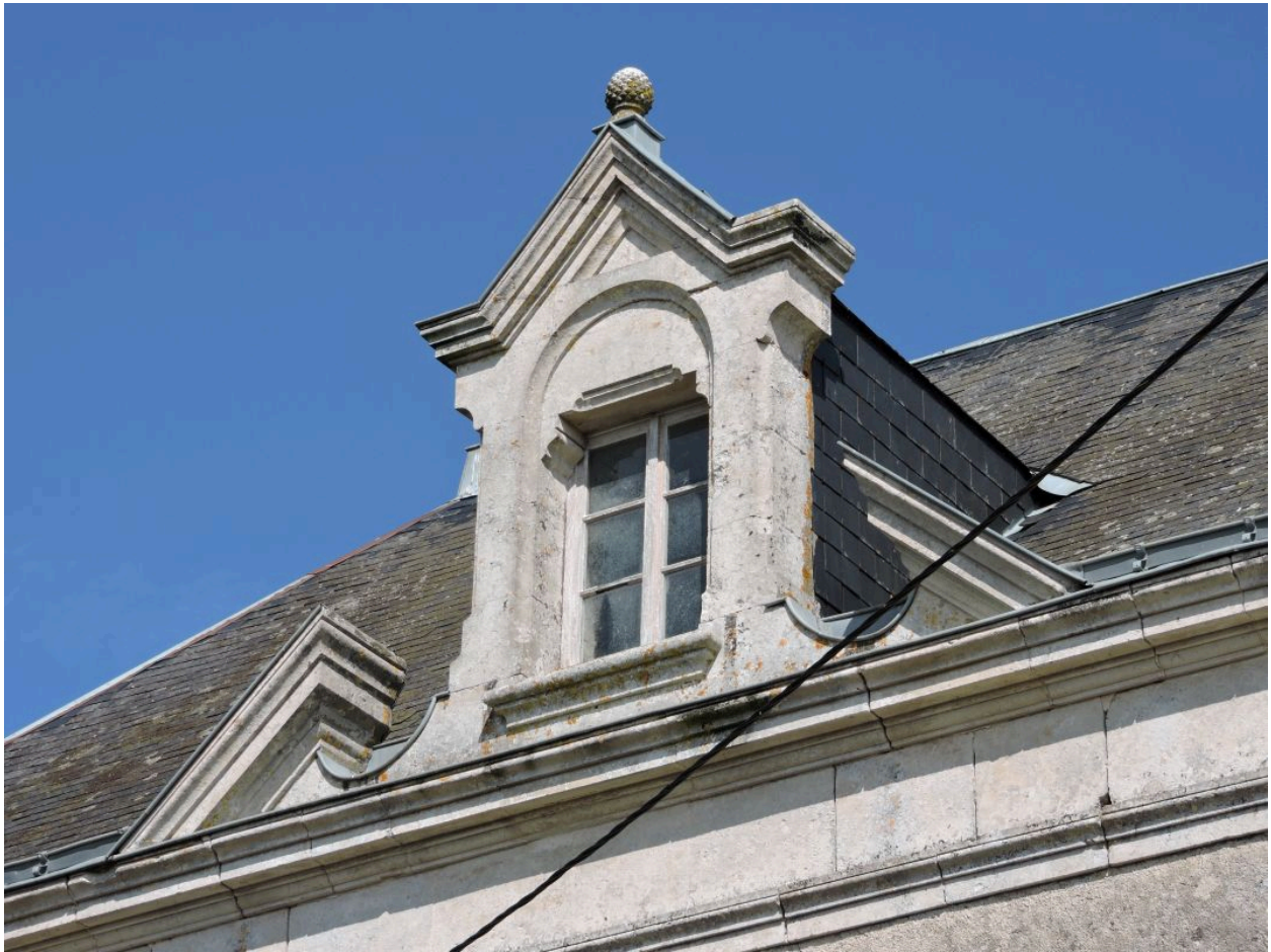
La lucarne au sommet de la façade ouest.
