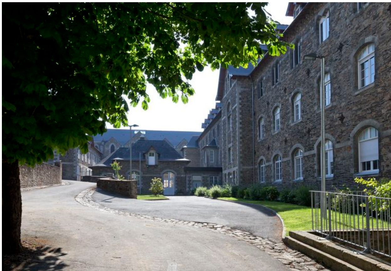
3 : bâtiment de la communauté, façade nord.
