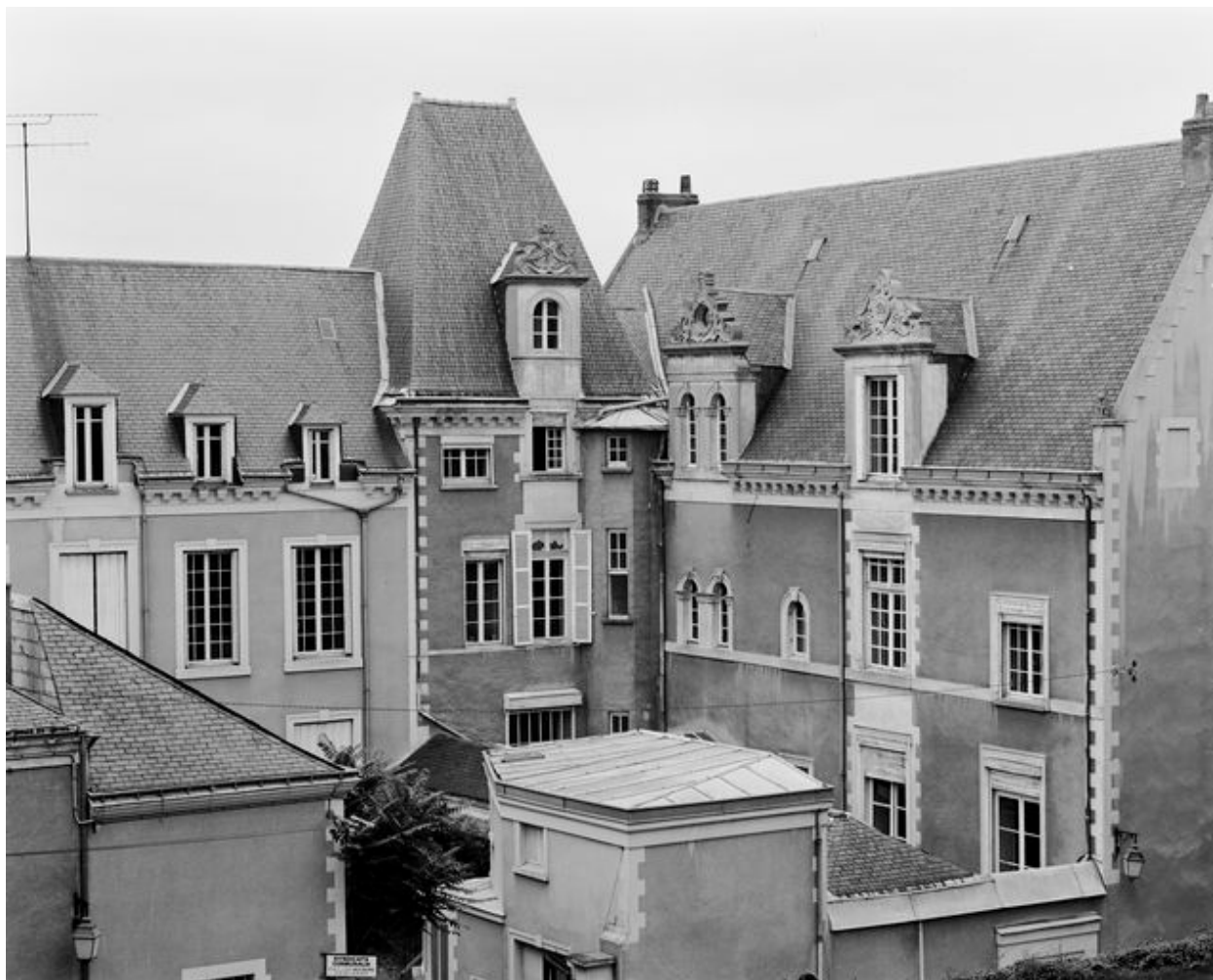
Bâtiments conventuels. Partie située au n° 2 et 4, dite logis de Goddes : angle des façades sud et est.
