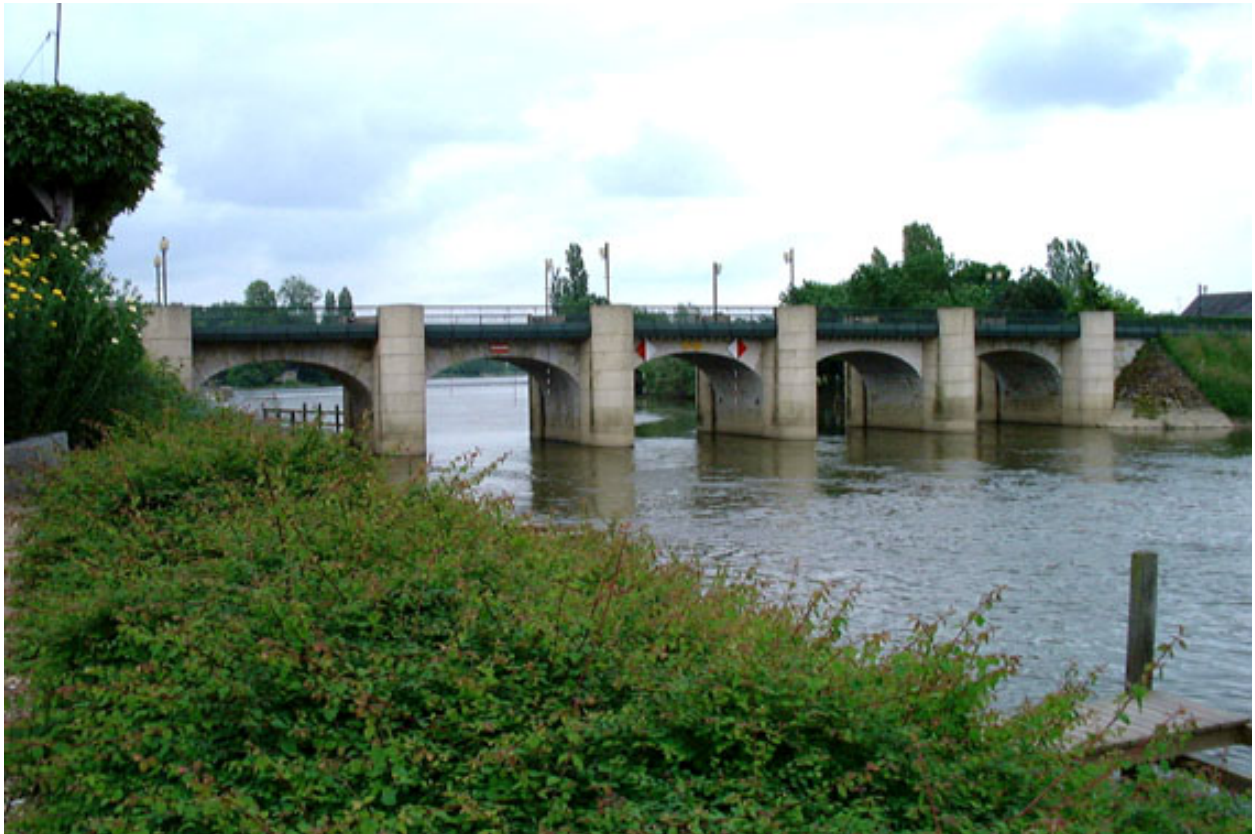
Vue du pont enjambant la Sarthe.
