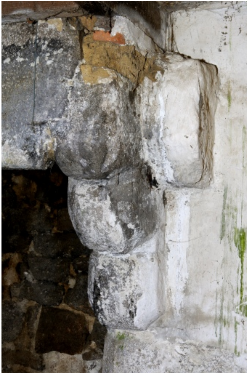
Détail du corbeau de droite de la cheminée est.
