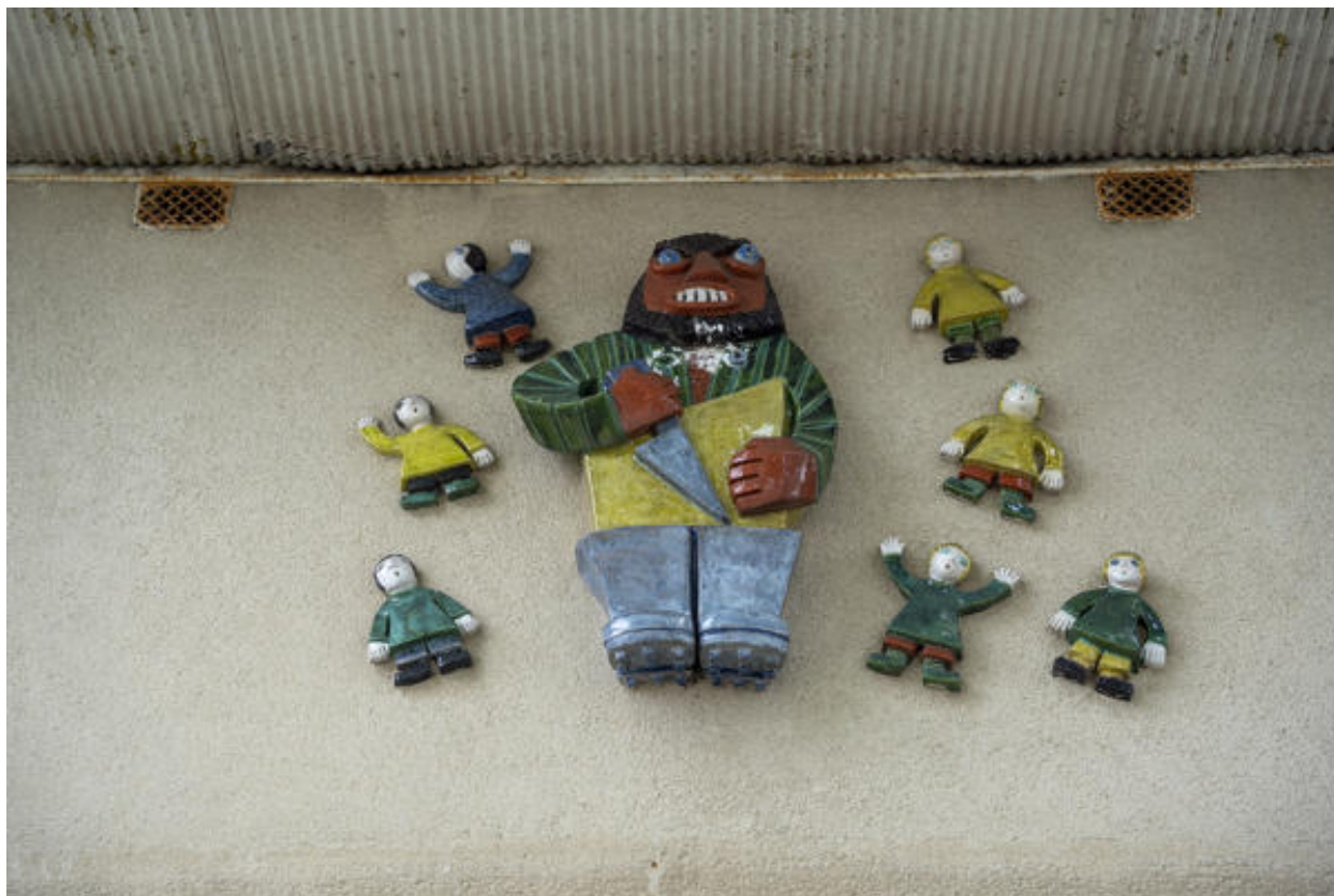
Vue de la sculpture émaillée en façade côté cour.
