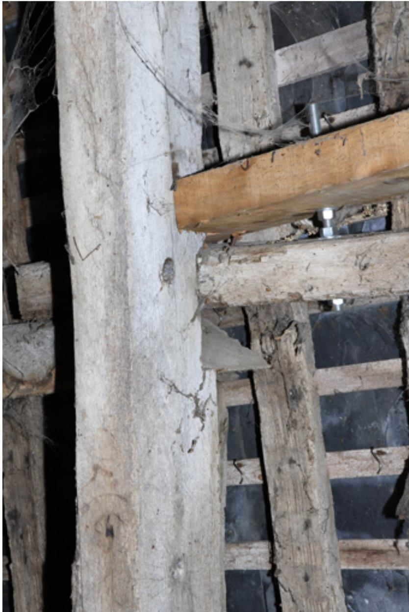
Logis. Charpente. Détail d'un arbalétrier avec embrèvement pour l'insertion d'une panne.
