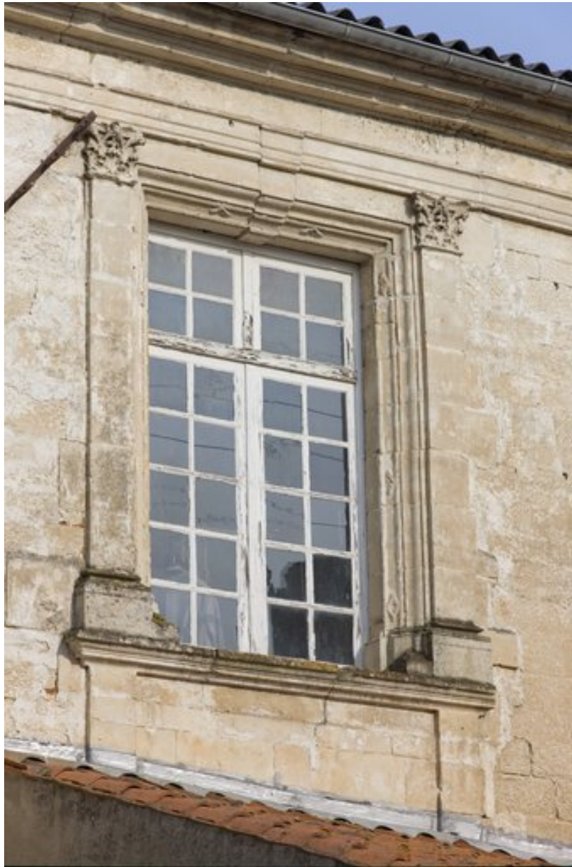
Fenêtre du XVI e siècle, à l'étage de la façade est.
