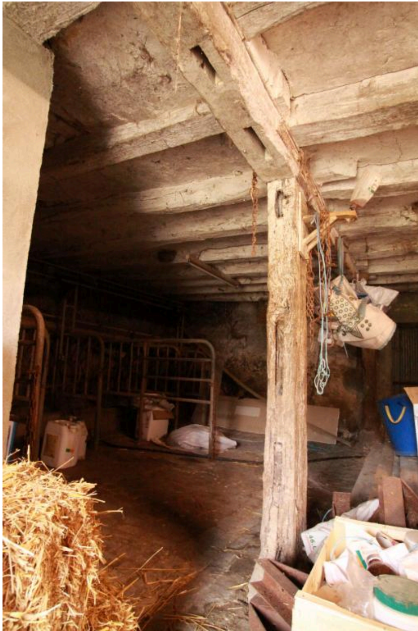
Grange-étable, fenils : détail structure en bois.
