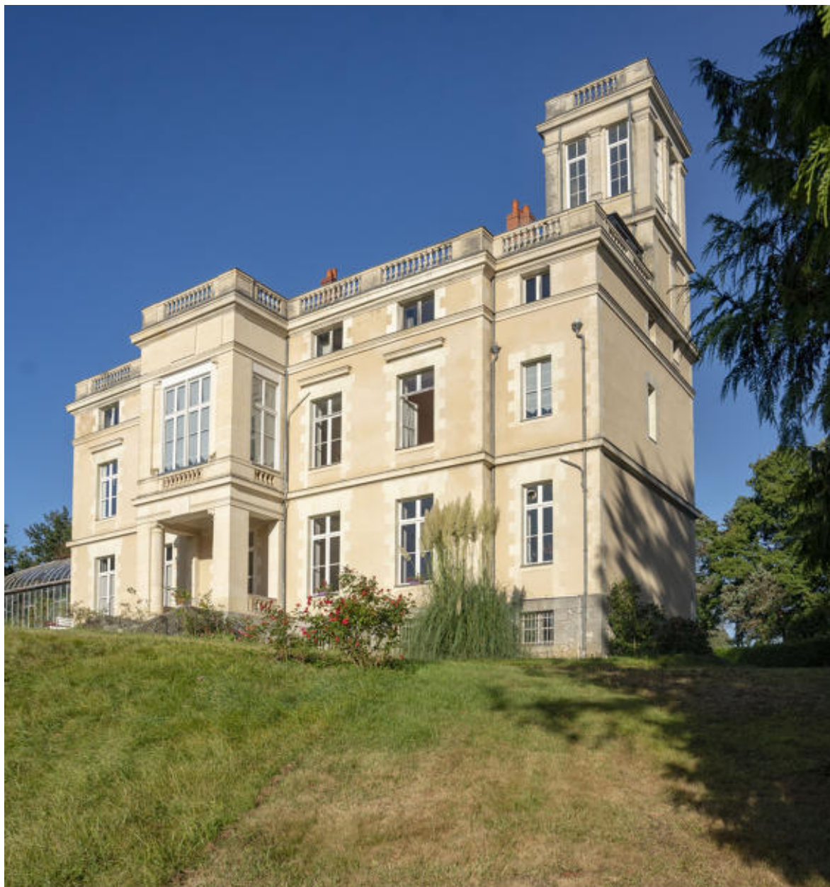
La façade antérieure du château.
