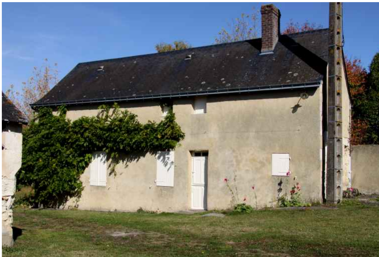
Maison 1, façade sur cour : comble à surcroît.
