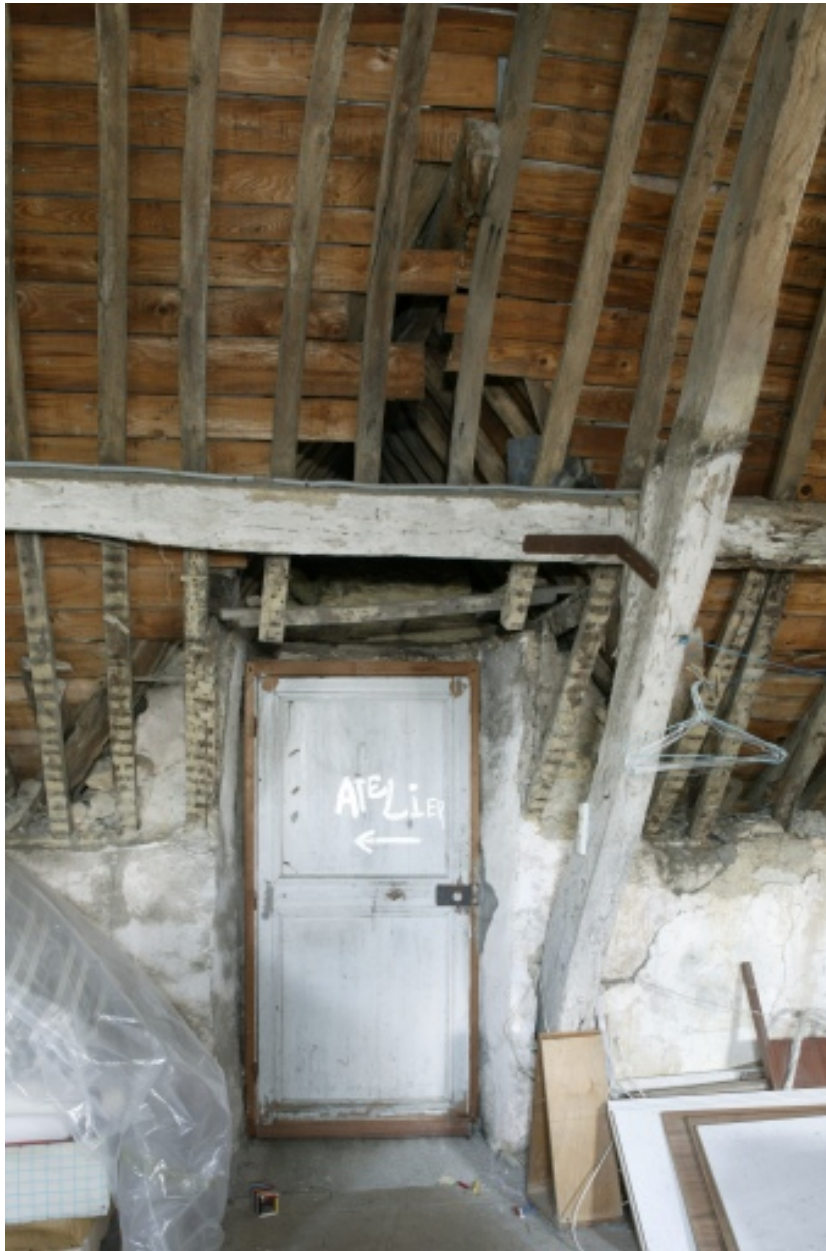
Charpente, détail du raccord avec la tour d'escalier.
