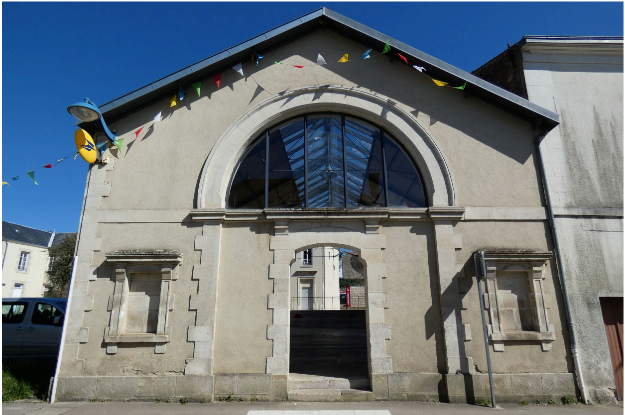
La façade ouest du préau.
