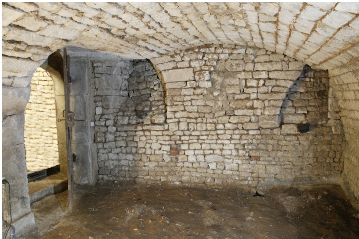
Vue du sous-sol.
