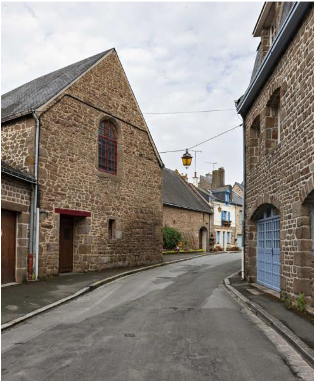
Bras nord du transept de la chapelle Notre-Dame du Rocher.
