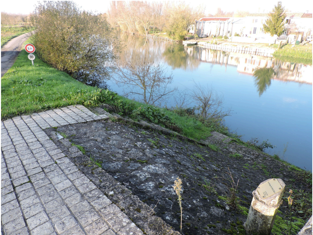
Perré et escalier en aval du pont, à l'angle sud-ouest.
