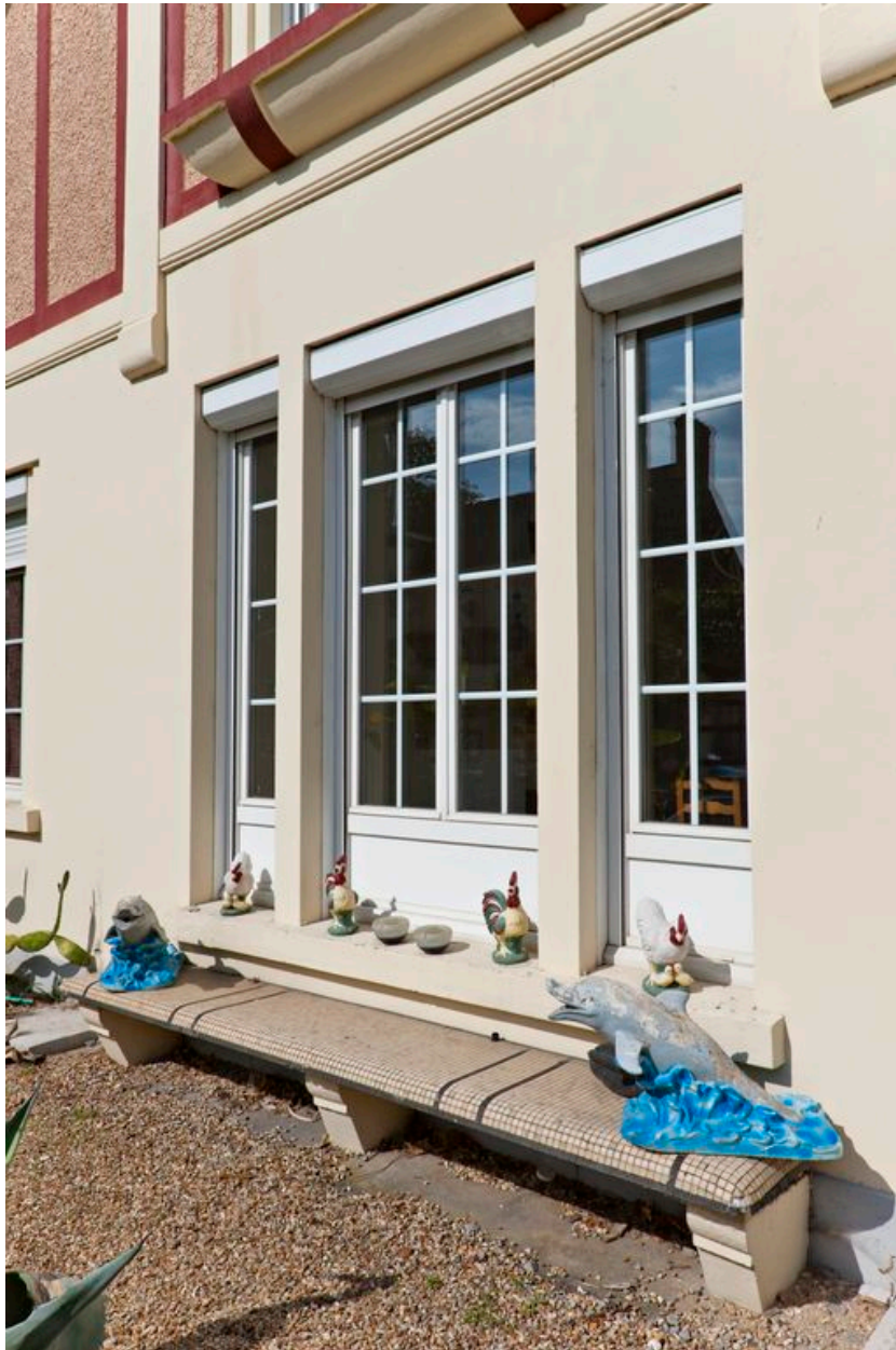
Façade antérieure, porte-fenêtre axiale, détail : bancs couvert de céramique.
