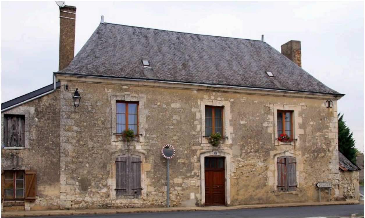
Façade antérieure sur rue.
