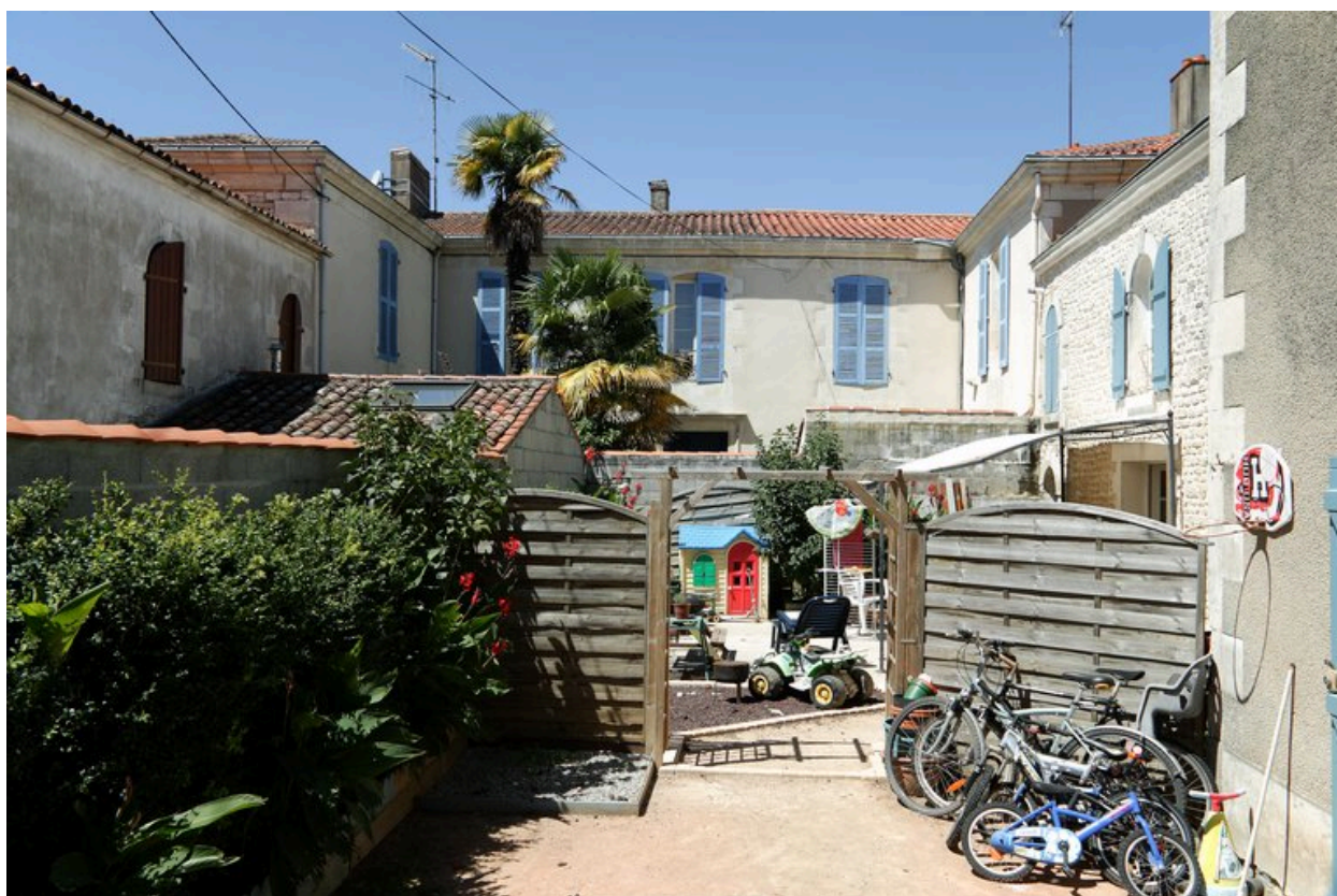
Vue d'ensemble prise de la rue Henry-Renaud, montrant les façades sur cour de la maison et les deux ailes de communs, aménagées en demeures.
