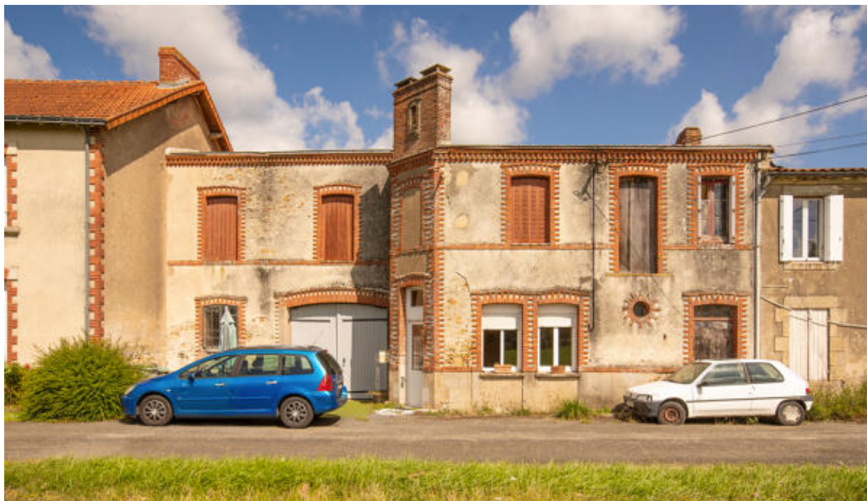
Vue générale des bâtiments depuis le sud.
