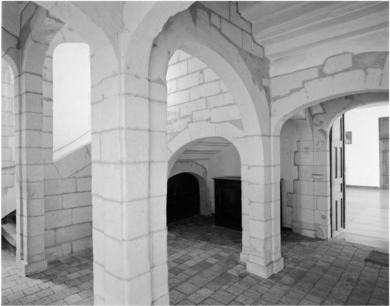
Aile sud du cloître, vestibule et grand escalier, depuis le nord-ouest. A droite, porte vers l'avant-choeur des religieuses.
