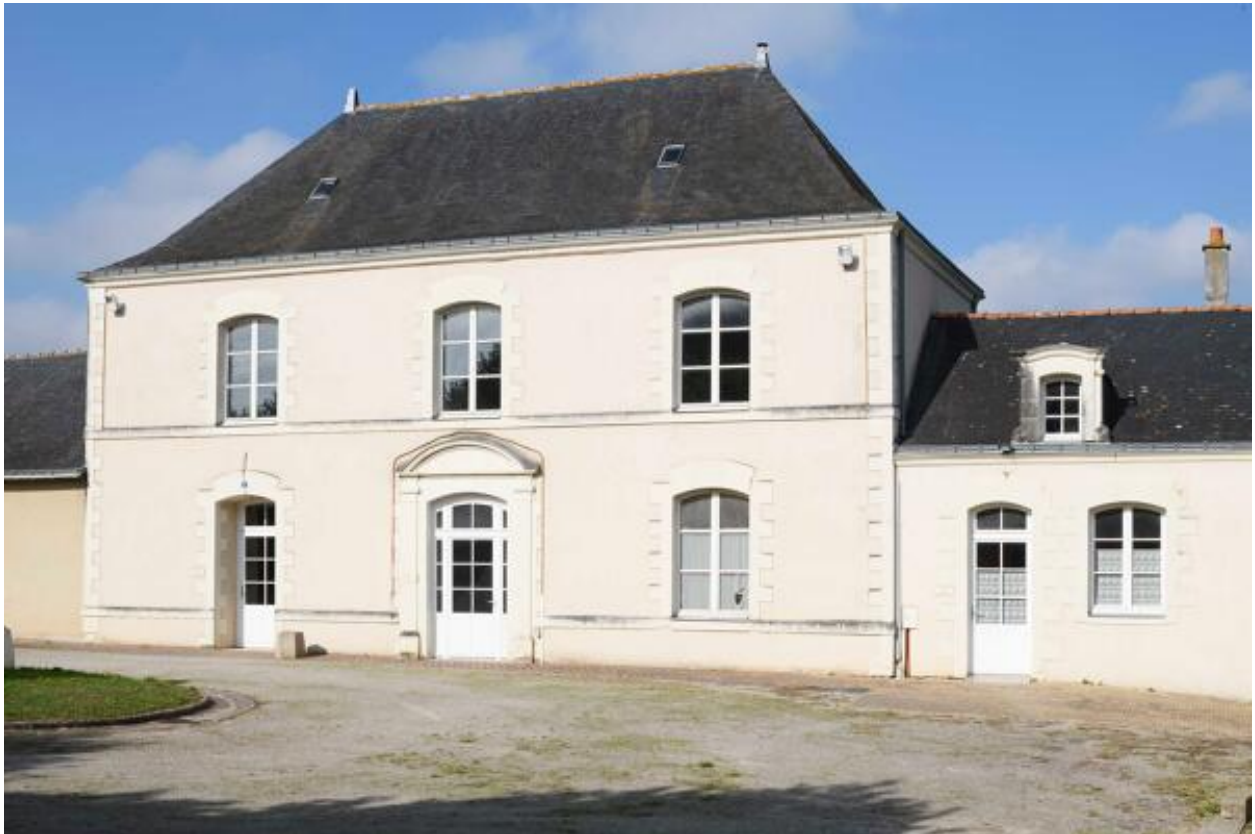
Vue de la façade est du presbytère.
