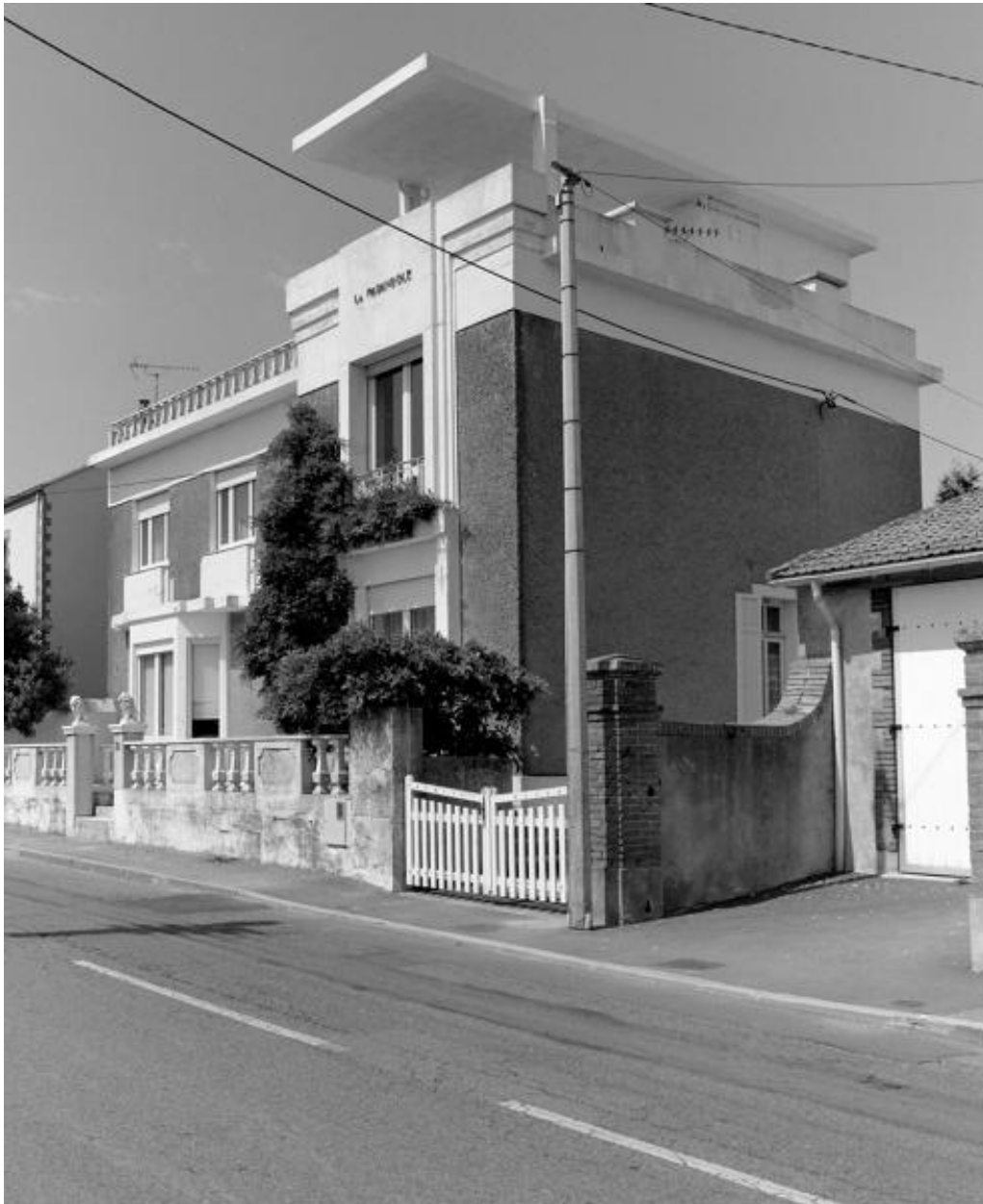
Elévation antérieure prise du sud-ouest.
