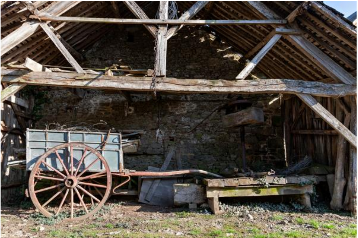
Hameau du Baz-Hazay, loge en pan de bois édifée contre le mur-pignon ouest de l'alignement nord, charrette et maie de pressoir en bois.
