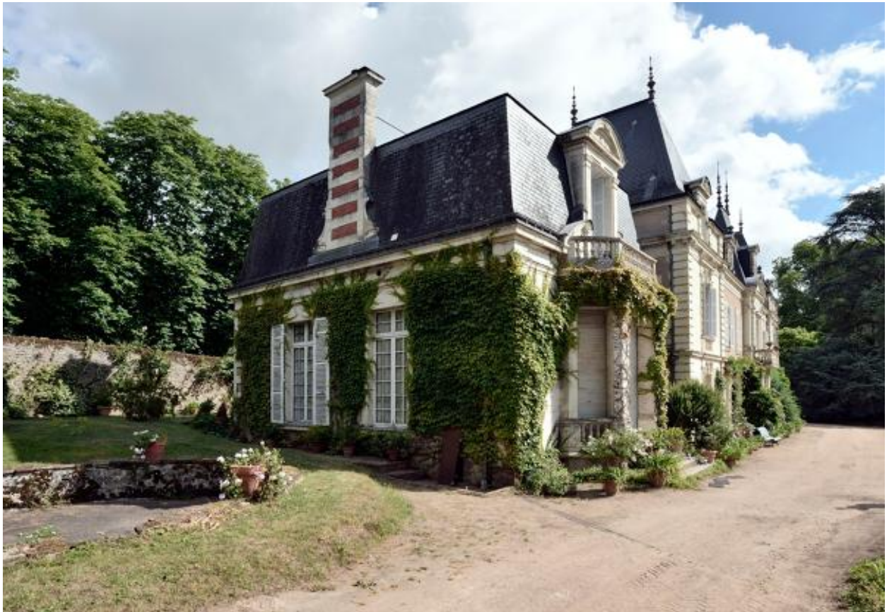
Les Vaults. Château. Vue depuis le sud-ouest.
