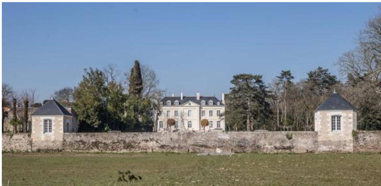
Façade sud sur jardin et pavillons.
