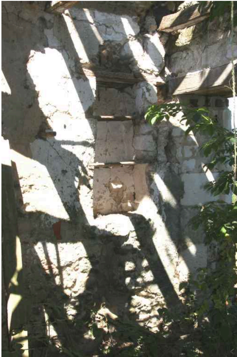
Maison n°2, pignon : placard dans le mur.
