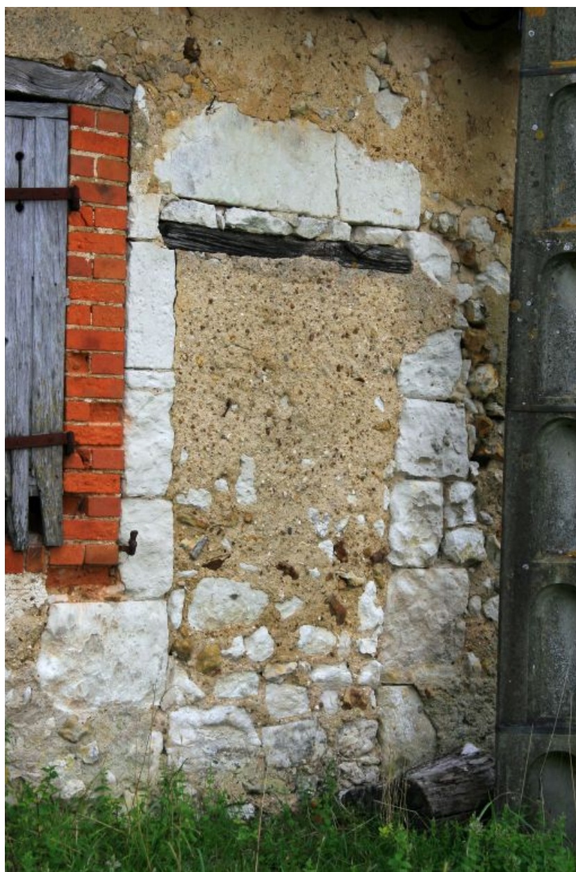
La maison, détail : porte obstruée (chambre froide ?).
