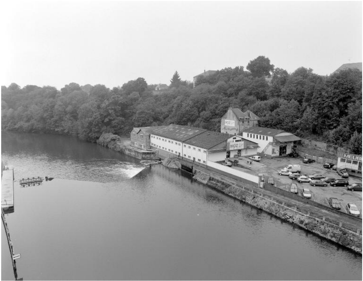
Vue d'ensemble du site du moulin détruit, depuis le viaduc.
