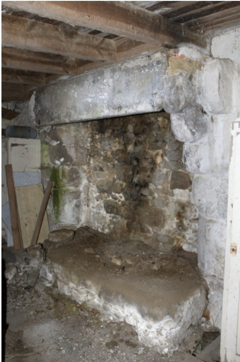
Vue de la cheminée est.
