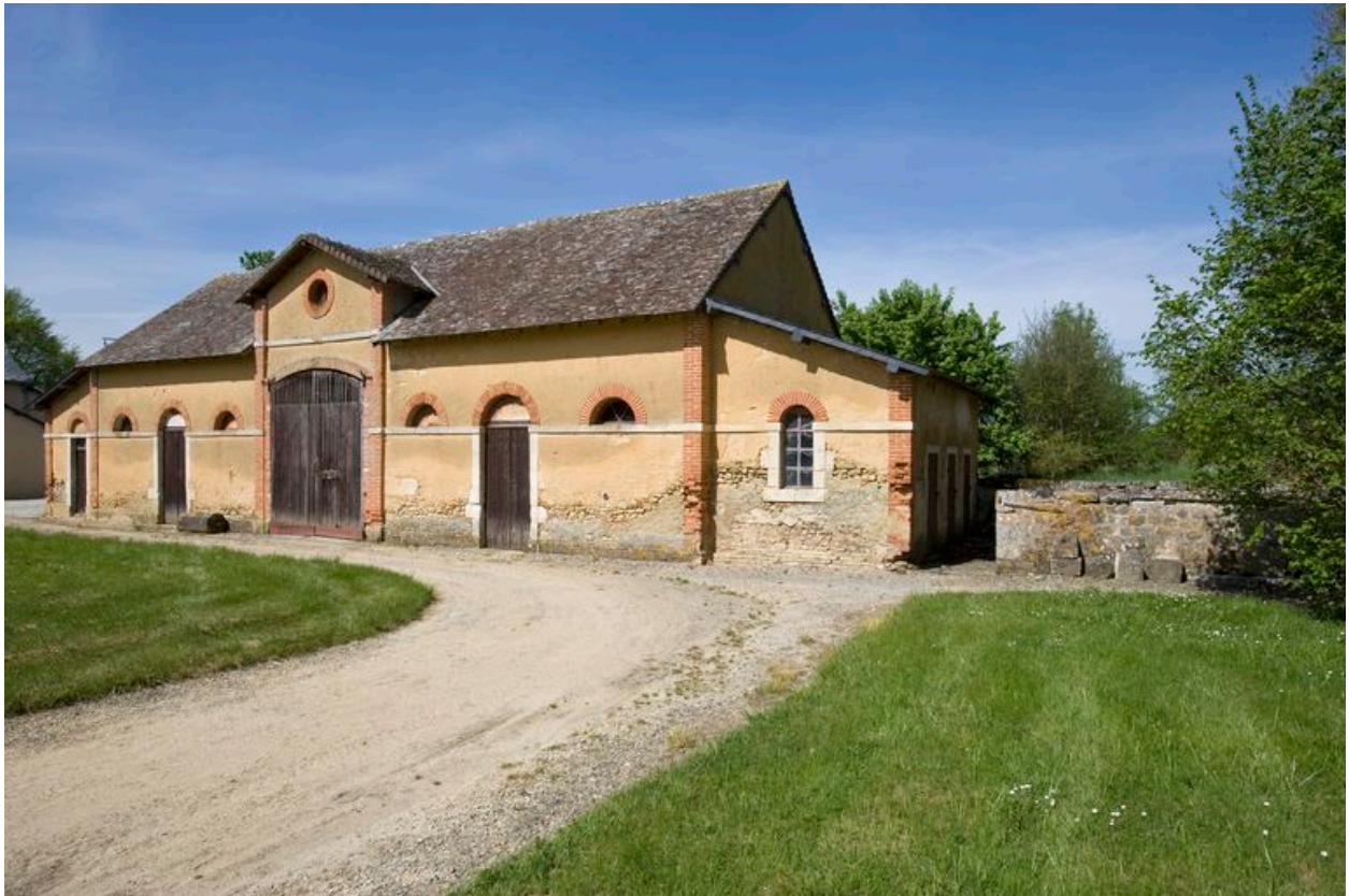
Grange-étable-pressoir et porcherie, vue depuis le nord.
