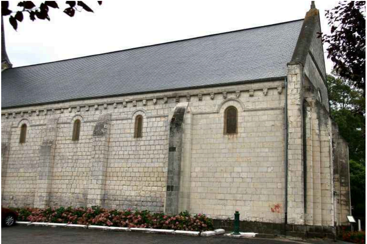
Mur nord de la nef : construction d'une travée supplémentaire.
