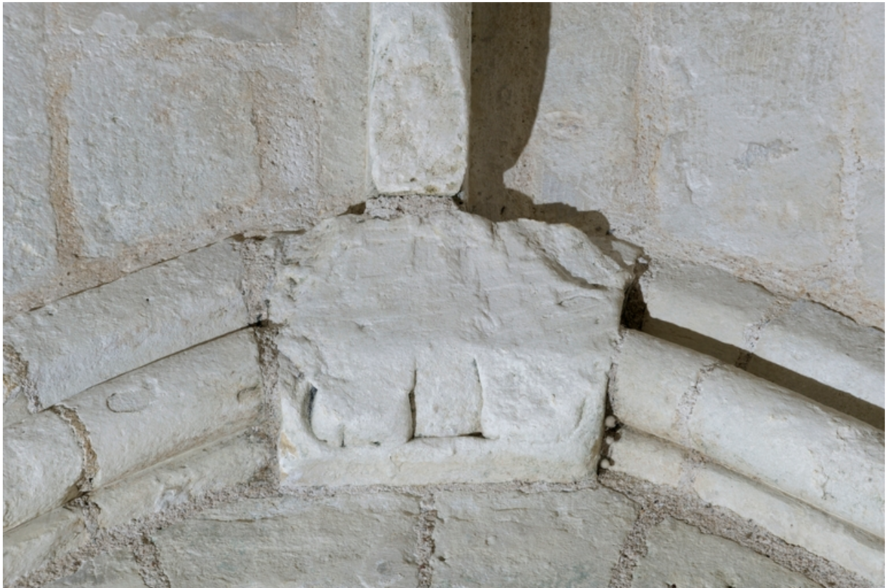
Chapelle haute, voûte, baie sud, clef du formeret : représentation non identifiée.
