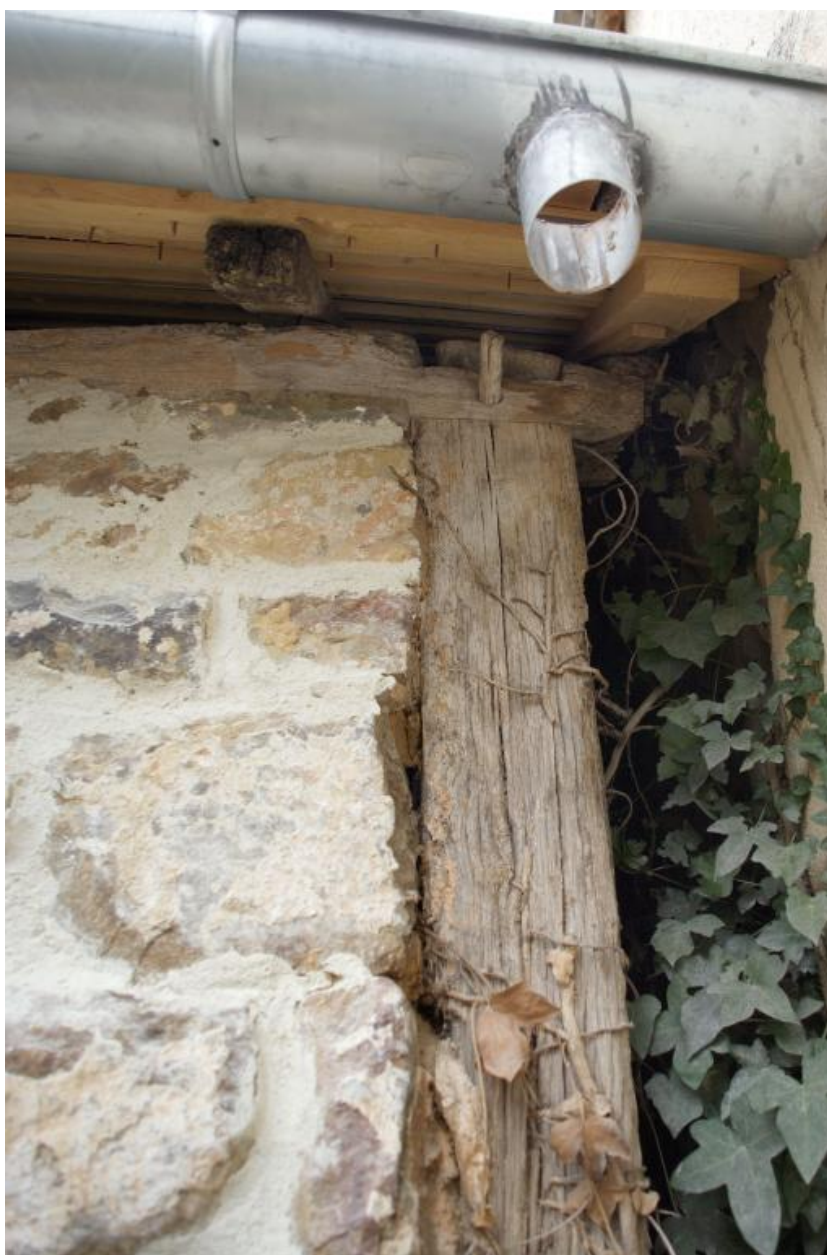
Détail de la façade principale : le poteau d'angle sud-est.
