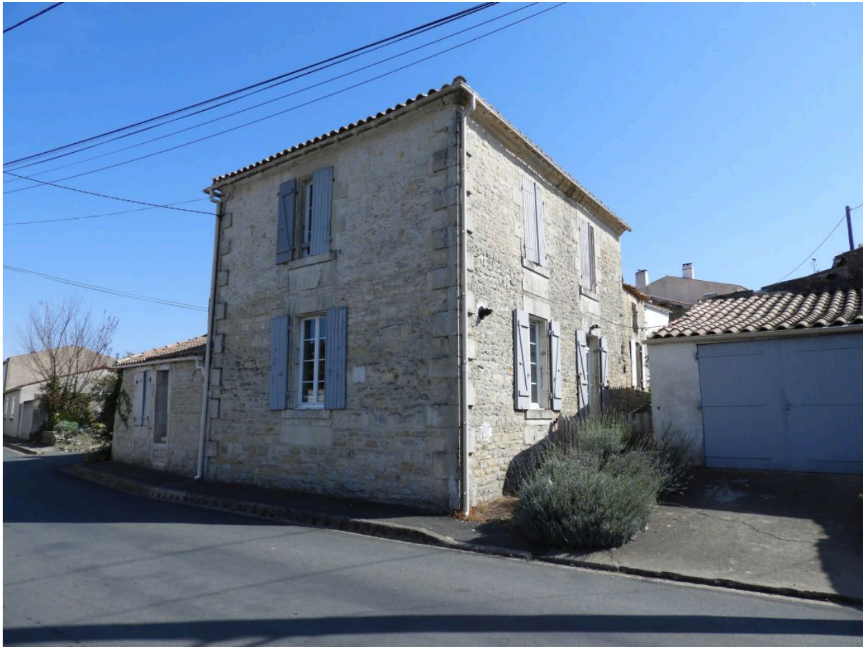
La maison vue depuis le nord-ouest.
