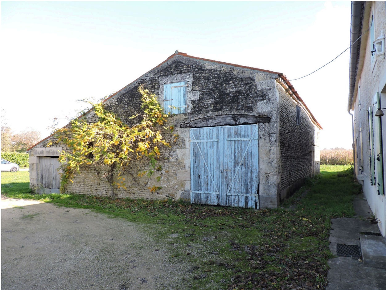
La grange-étable au nord du logis, avec façade sur le mur pignon, vue depuis l'ouest.
