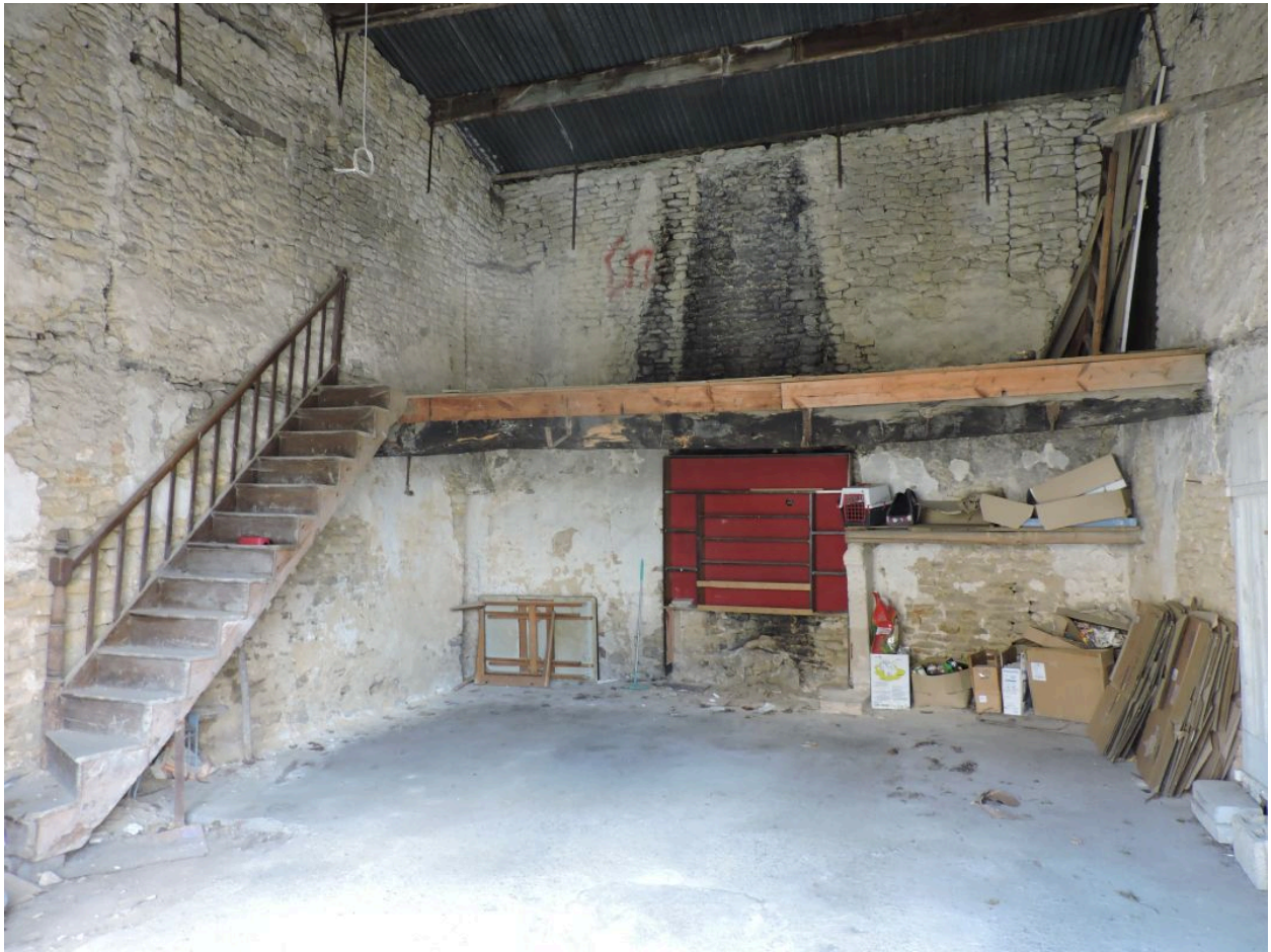
Vestiges de cheminée à l'intérieur de la dépendance.
