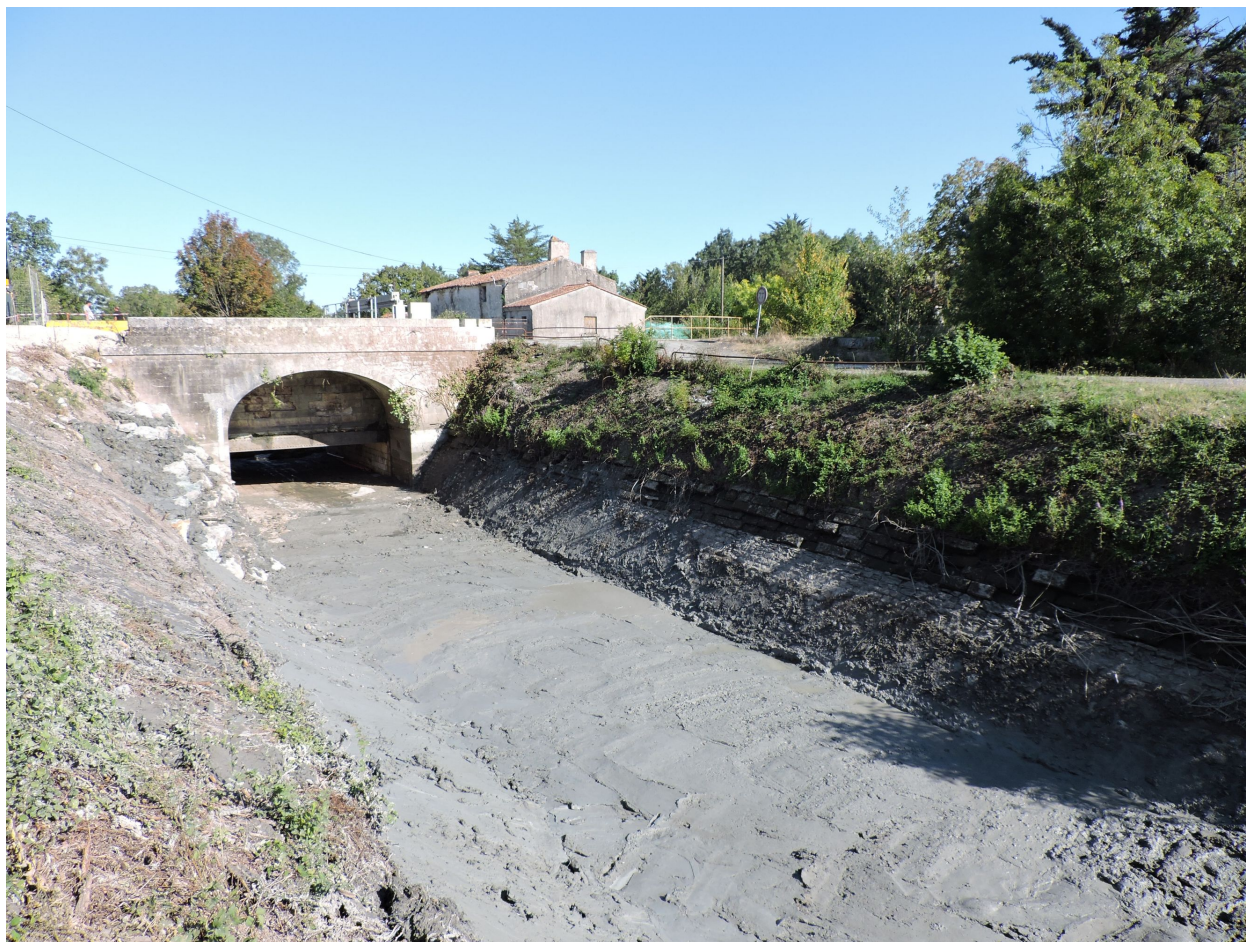
Août 2020 : le canal de Vix et l'aqueduc vus depuis l'aval.
