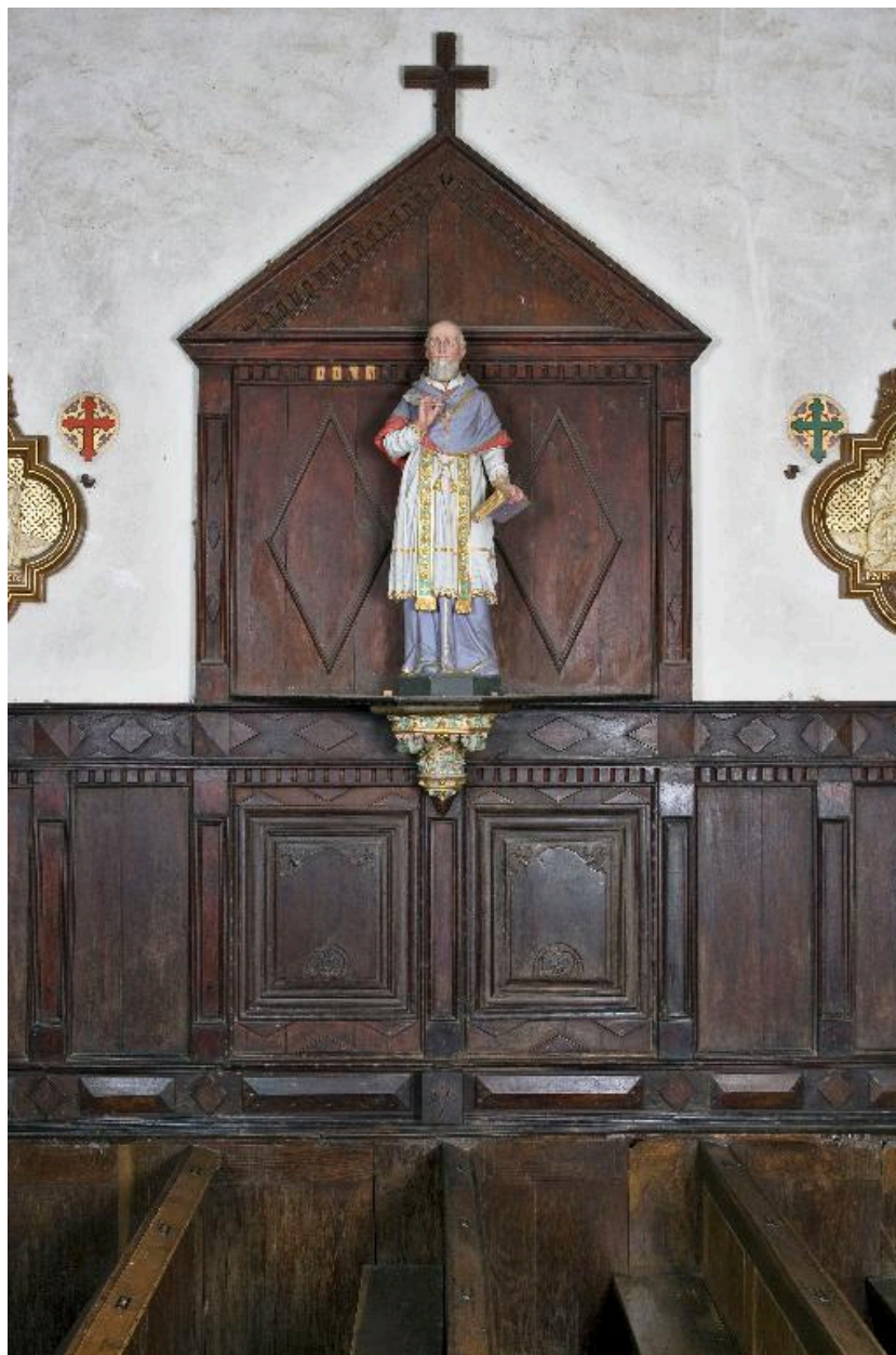
Partie centrale des lambris du mur sud de la nef.
