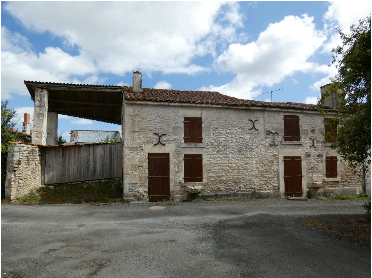
La maison entre son hangar et la maison voisine, vue depuis le nord-ouest.
