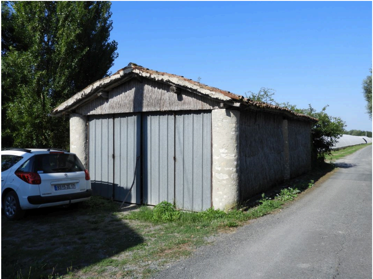
Le hangar à l'ouest de l'ensemble, vu depuis l'est.
