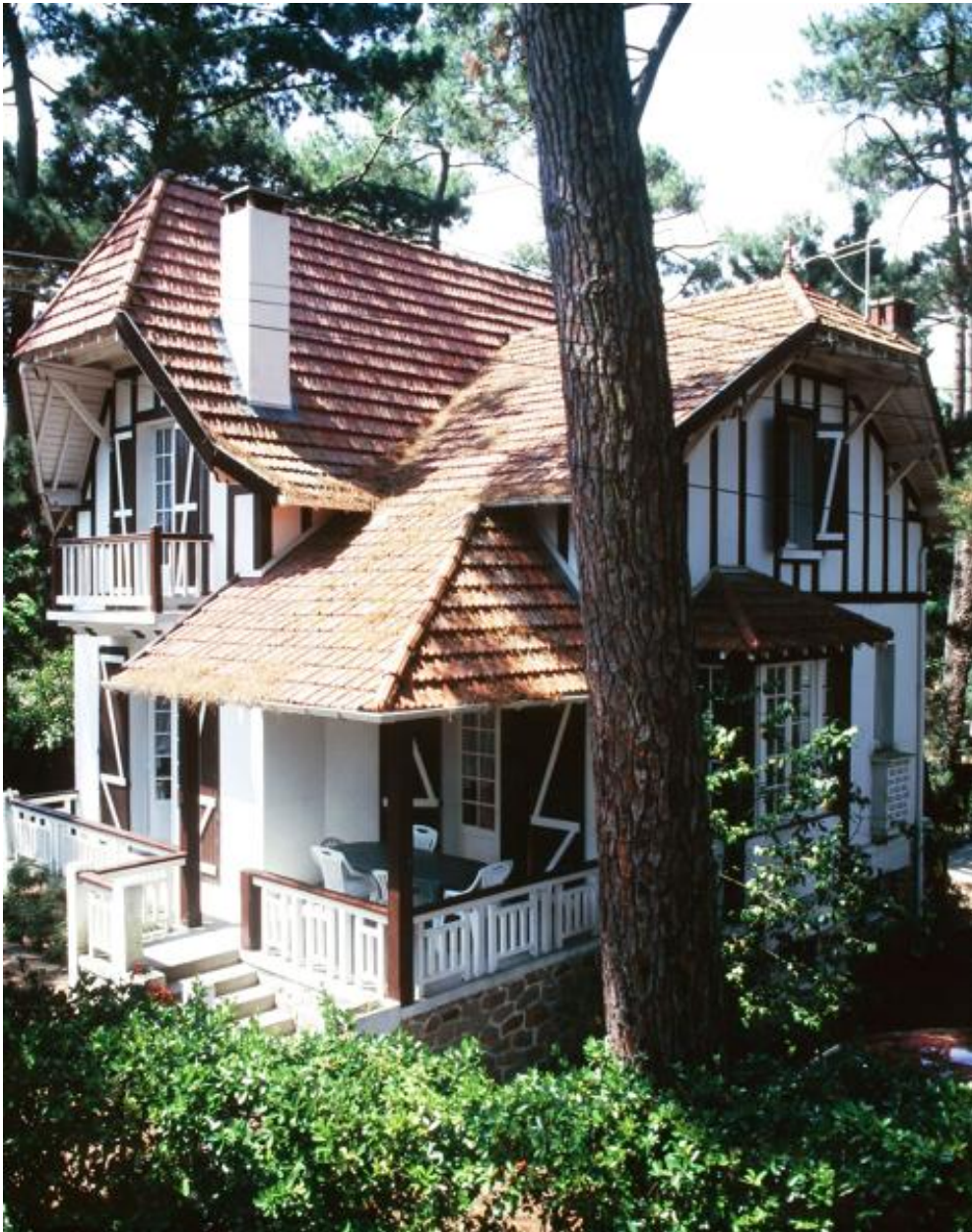
Villa la Johannée. Elévation de trois-quarts, vue de l'est.
