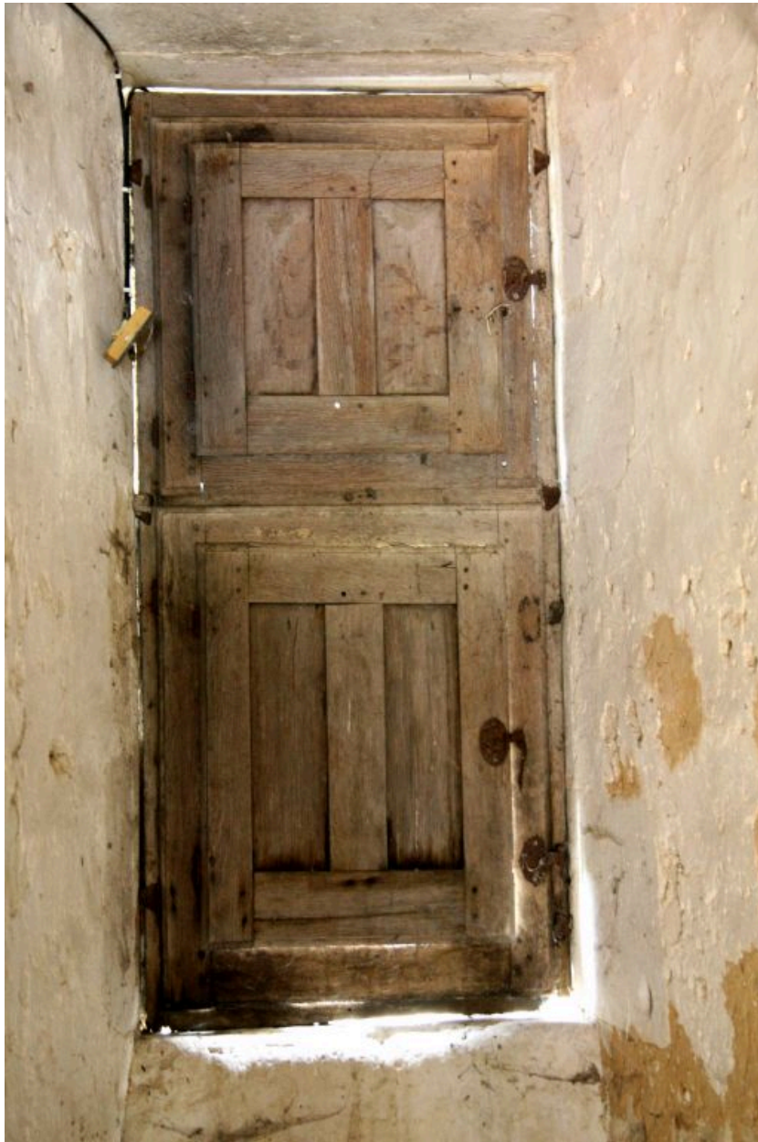
Tourelle, 1er étage : fenêtre avec volets.
