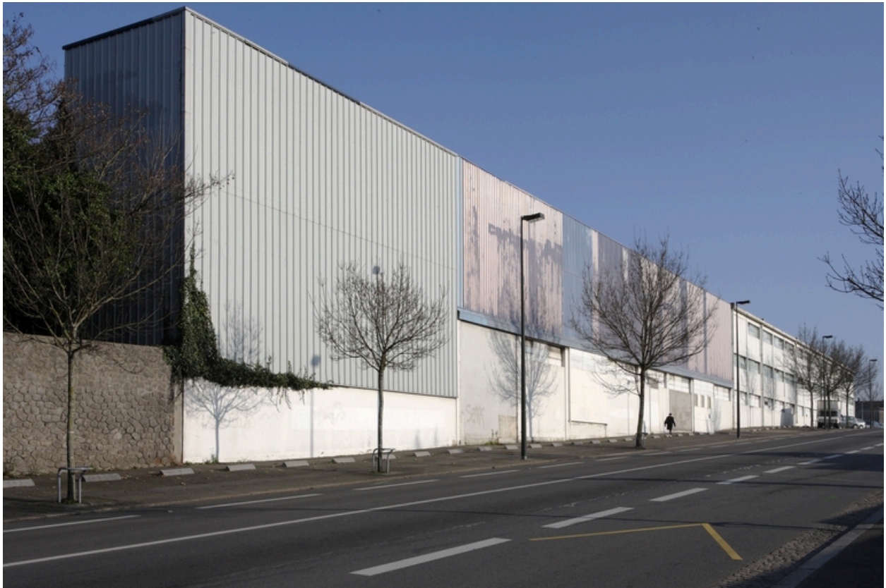
Atelier de fabrication 1, côté rue.
