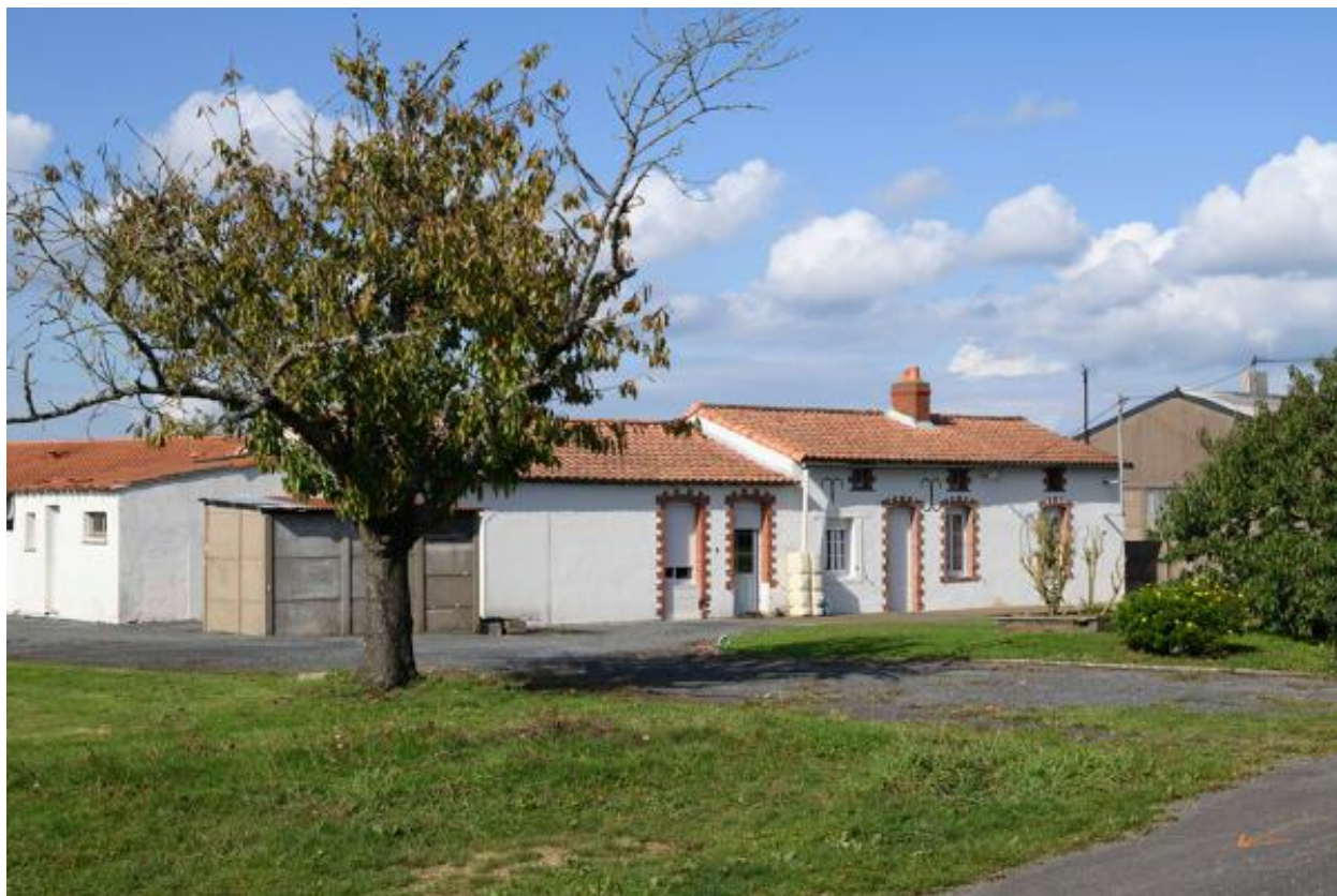
Vue d'ensemble de la ferme dite Pichon.
