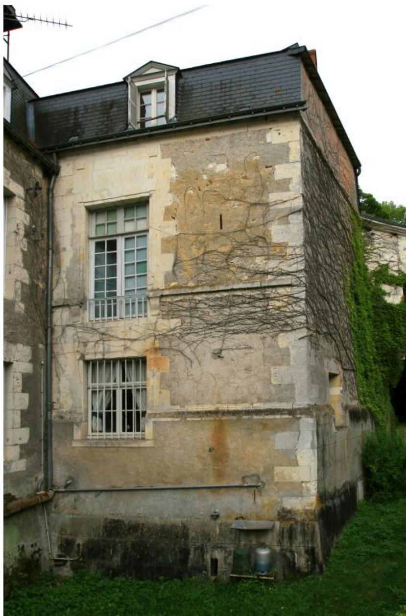
Aile nord, face est : travée de baies.
