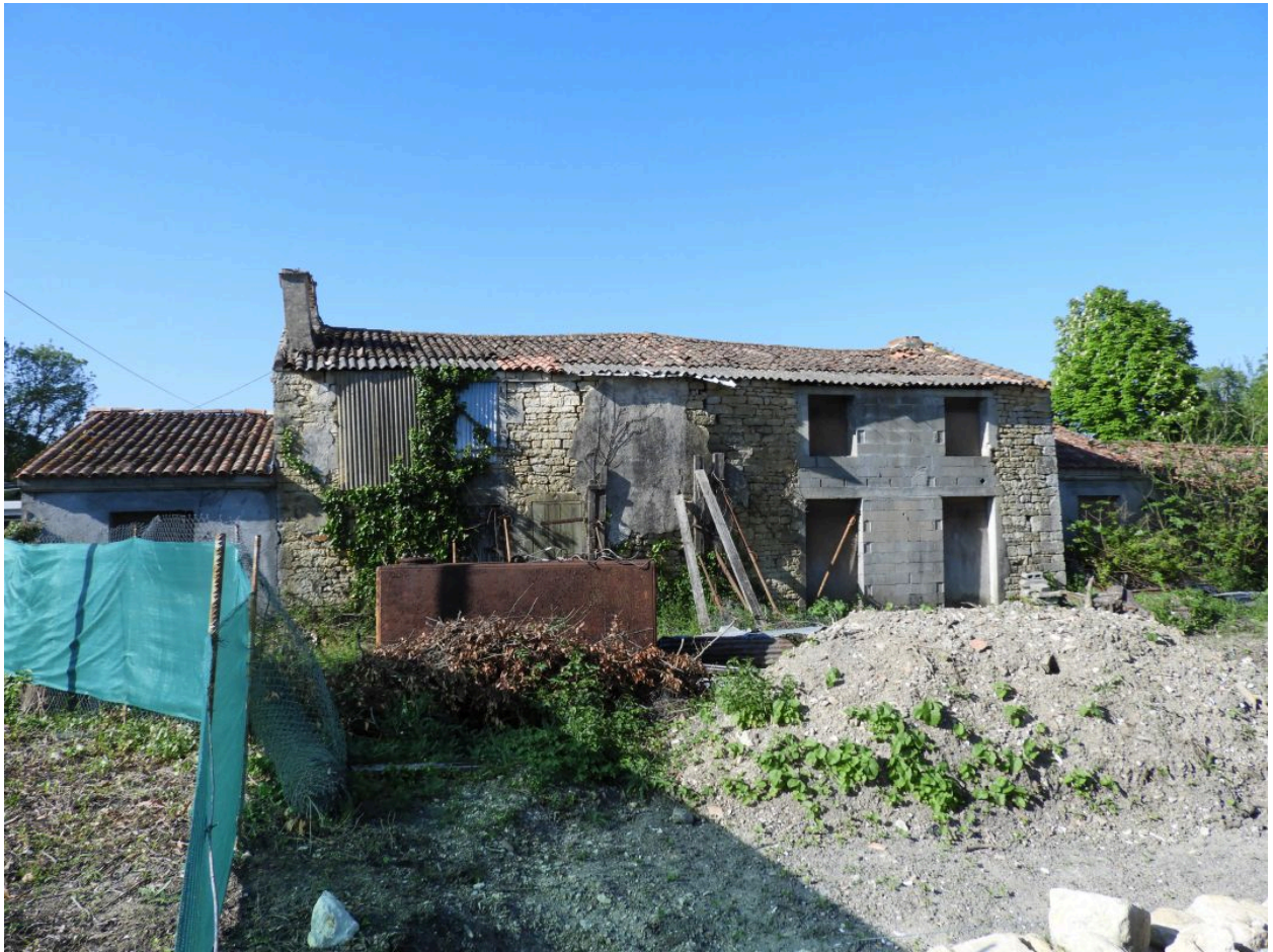
La maison de garde de l'aqueduc vue depuis le sud. Au premier plan, l'endroit où passait le Contrebot avant 1845.
