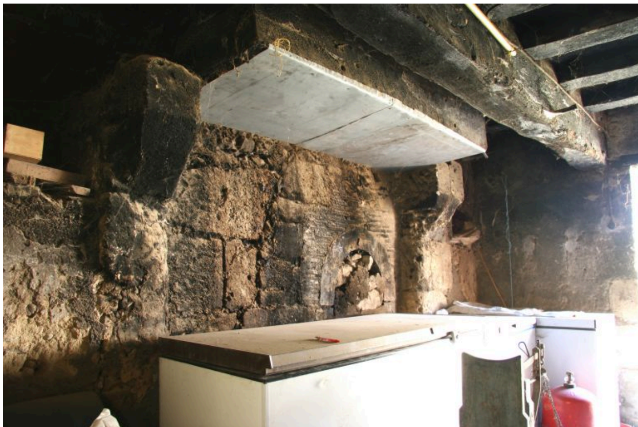
Maison 1723 : cheminée avec bouche à four.
