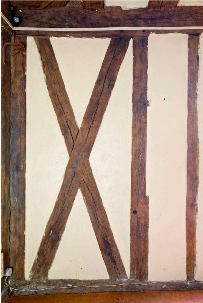
1er étage, pièce principale : face antérieure, partie à gauche de la fenêtre, avec l'un des poteaux d' huisserie de la fenêtre d'origine (déplacée), ayant conservé l'élément d'attache de la traverse.
